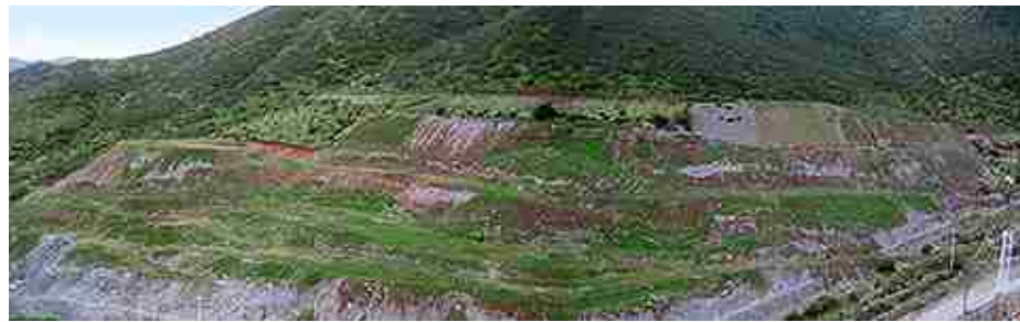
Etapa de cierre, septiembre 2014. Duración estimada 6 meses. Duración real 3 años. Actividades Ejecutadas: Estabilización talud, canal de contorno, sistema de drenaje, nivelación plataforma, cobertura vegetal, siembra, plantación, cerco, señalética.
