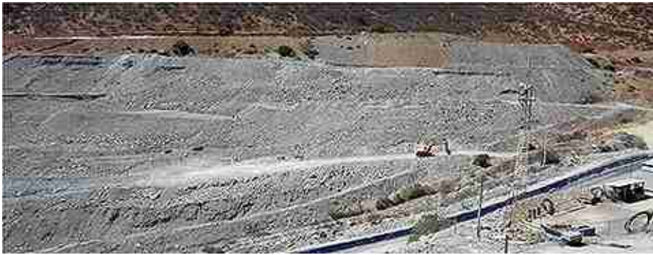
Condición final de operación, marzo 2014. Duración real Etapa de Operación 5 años. Capacidad utilizada 250.000 m3.
