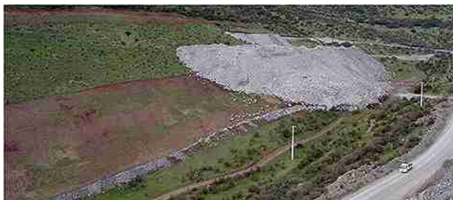
Etapa de Operación, septiembre 2006. Duración estimada 10 a 12 años. Capacidad proyectada 500.000 m3. Superficie intervenida 40.000 m2 (4 ha).
