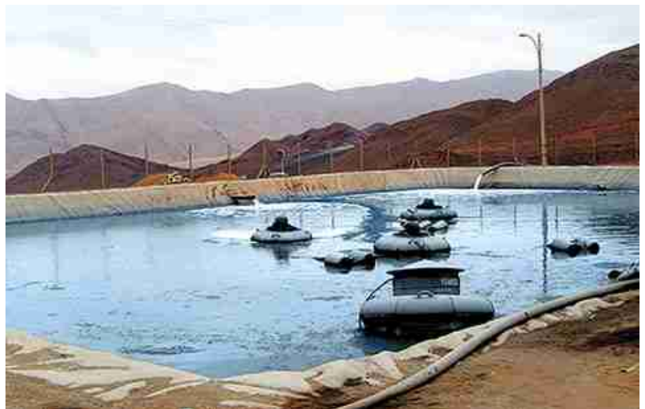
Piscina de recepción de agua de mar, Cifuncho, Taltal.
