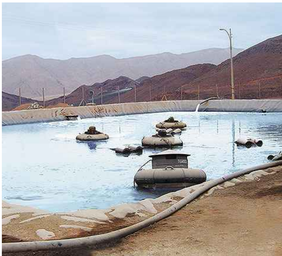
Piscina de agua industrial, Cifuncho, Taltal.
