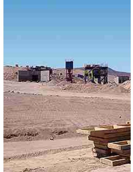
Trabajos en Planta de Óxidos.
