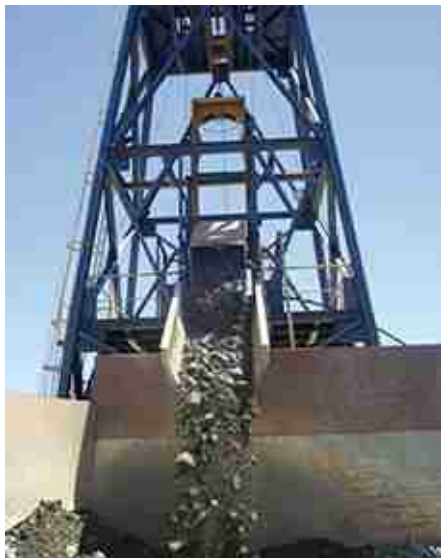
Pique de extracción (Peinecillo, Skip vaciando el mineral y chute de descarga).
