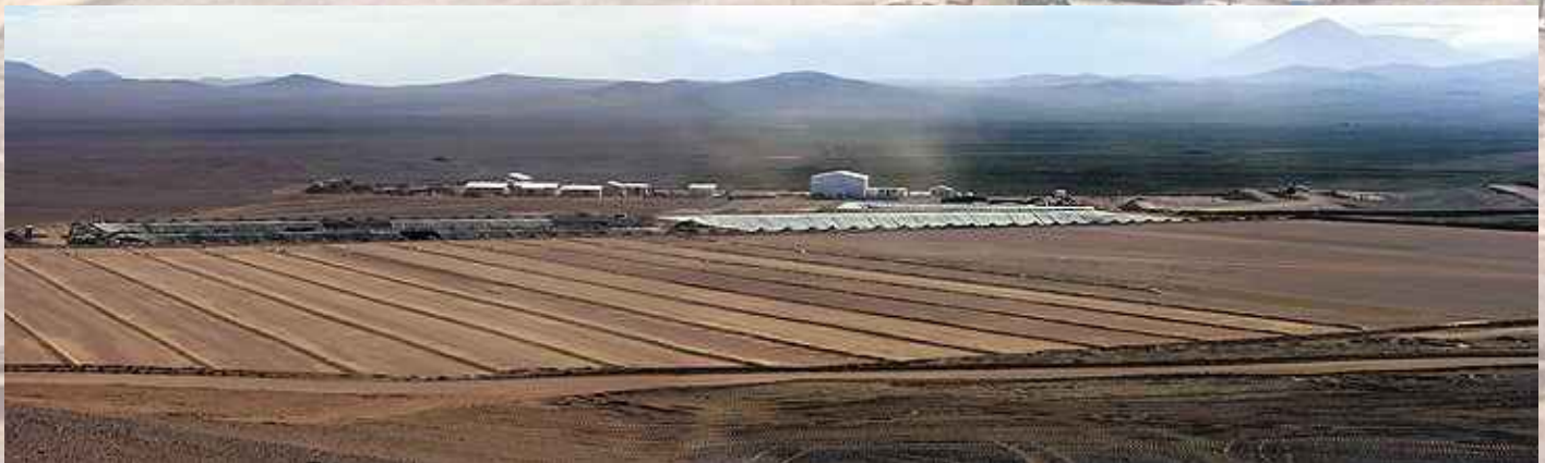
Área de Lixiviación en Pilas - Proyecto Planta de Óxidos.
