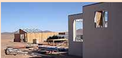
Construcción de oficinas.
