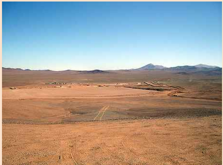
Vista panorámica del Proyecto.
