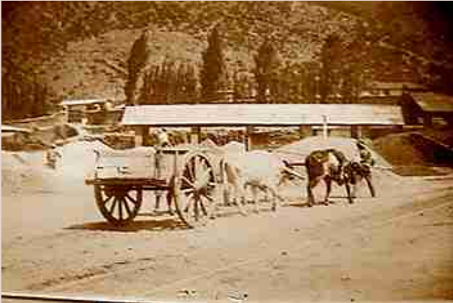
Cancha de acopio de minerales.
