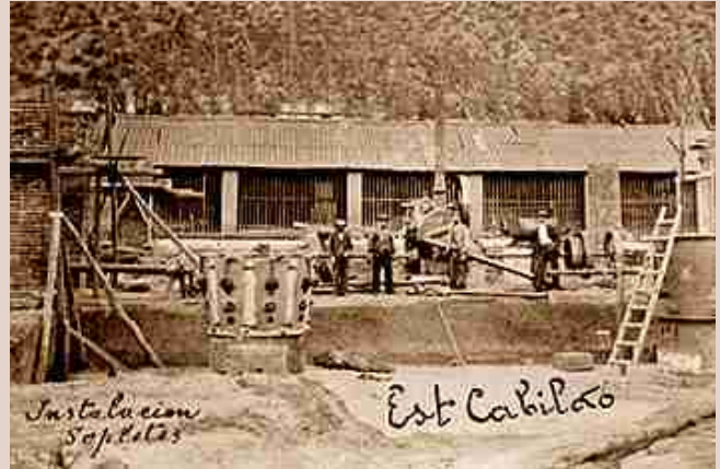
Antigua Estación Cabildo.
